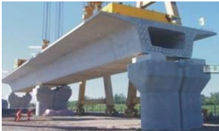
Hình 1.20. Dầm cầu bê tông cốt thép ứng lực trước
