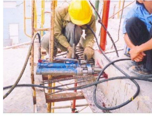
Hình 1.8. Máy kéo căng lồng cốt thép loại đơn cấp
