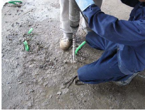
Hình 1.15. Khoan tạo lỗ khi căng cáp.
