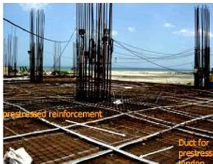
Hình 1.16. Cấu tạo cốt thép ống thép trong bê tông
